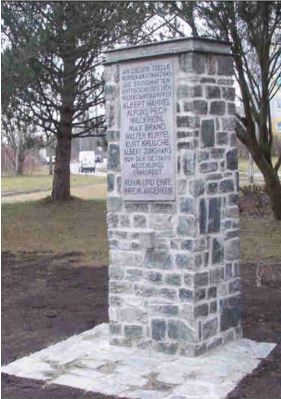
Denkmal für sieben am 27. März 1945 von Faschisten ermordeten Antifaschisten. Nach der Sanierung am 27. März 2015.
